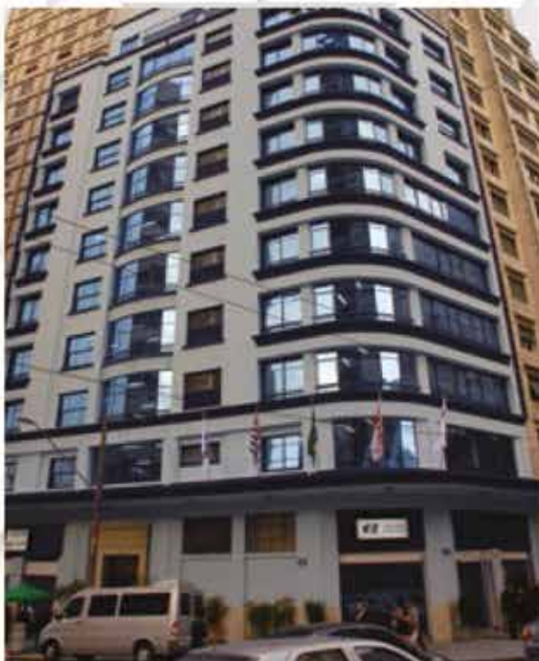
Prédio-Escola CIEE Geneva Rua Geneva, 65/67, Centro Antigo de São Paulo/SP.
